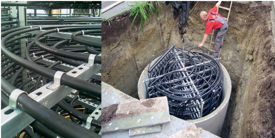
Abbildung 9: Eisspeicher (Quelle: www.viessmann.com 2018)
