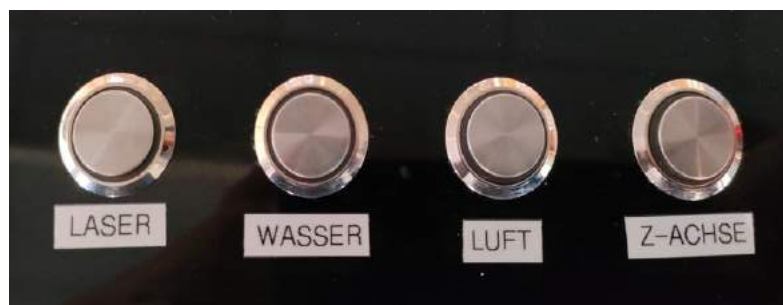
Abb.: 186 Schalter die eingebaut wurden
