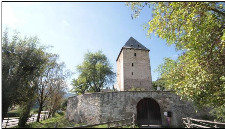
Abbildung 9 Mittelalterlicher Wehrturm von Baierdorf, 11. Jahrhundert. Online verfügbar unter: https://www.natura.at/de/Ausflugsziele/Zehent-Wehrturm-Baierdorf_p2060?msckid=276c9928ced211ecb7aed35243d0c54f [aufgerufen am 29.11.2021].
